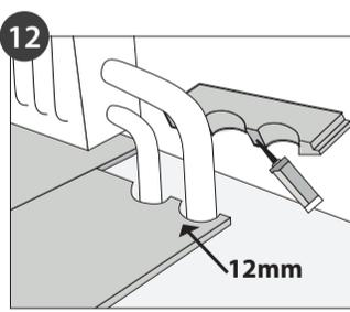
Müssen Sie einen Ausschnitt für Heizkörperrohre, Pfeiler, Trennwände oder sonstiges vornehmen, dann achten Sie auch dort auf den ca. 12 mm Abstand zu den Bauteilen.
